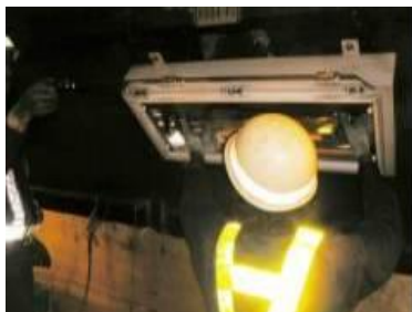
トンネル照明設備清掃・点検
