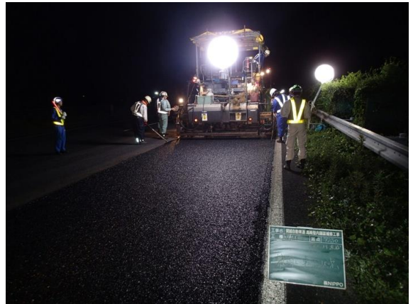
路面補修状況
