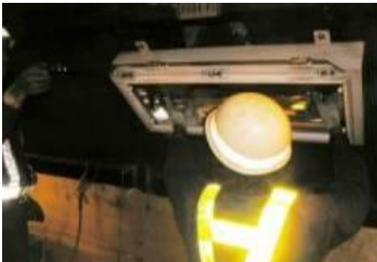
トンネル照明設備清掃・点検
