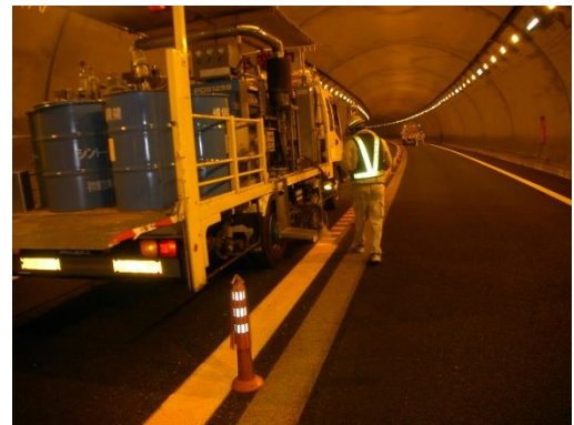
路面標示工の設置
