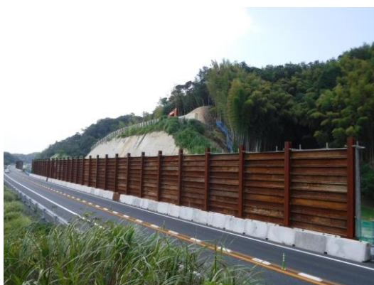
落石防護柵の撤去前
