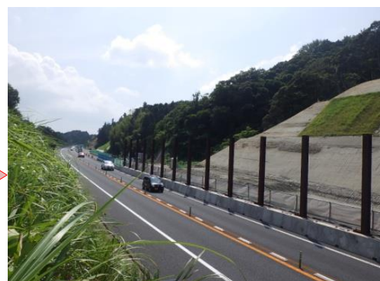
落石防護柵の撤去後
