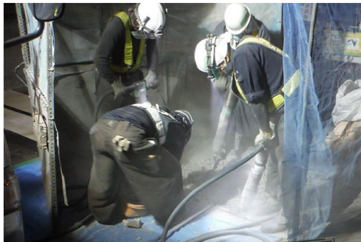
伸縮装置取替状況
