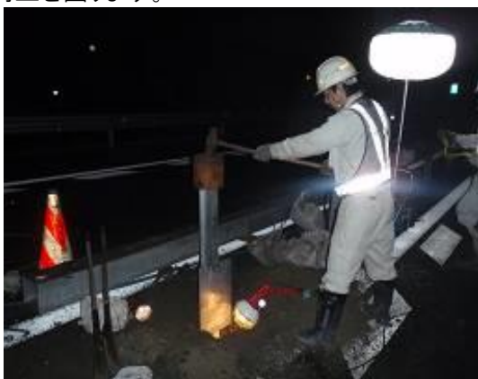
防護柵の取替え
