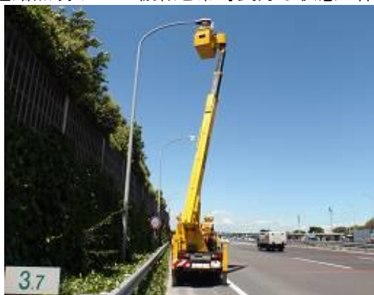
道路照明の点検
