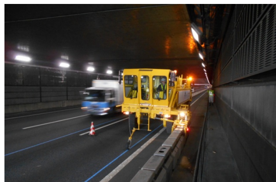
《作業状況(常磐道)》
