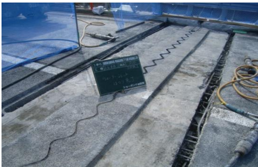
1.伸縮装置撤去
