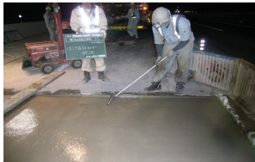
4.コンクリート打設
