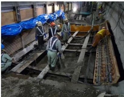
②掘削～型枠～コンクリート打設
