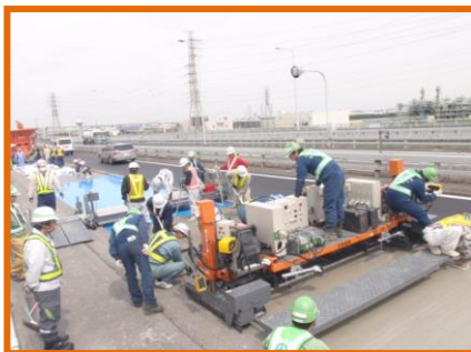
【鋼繊維補強コンクリート打設状況※】
