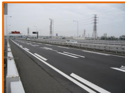
【アスファルト舗装の完了※】
