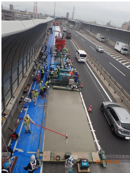
写真-1 鋼繊維補強コンクリート施工状況
