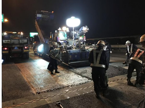
舗装補修工事
