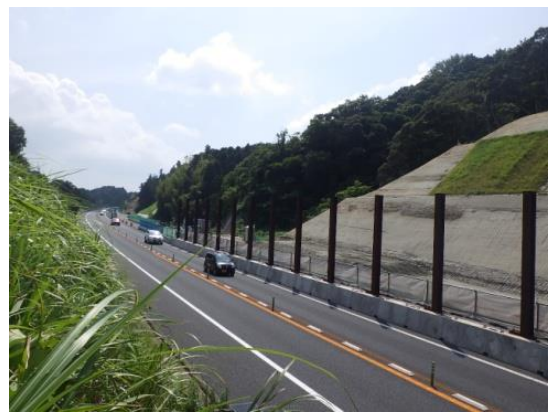
落石防護柵の撤去後
