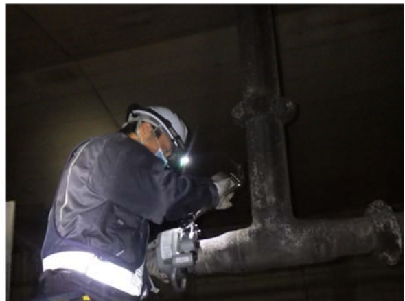
トンネル横断配管取替状況
