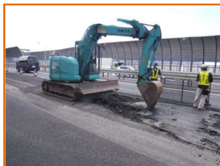
【アスファルト舗装はぎ取り状況※】
