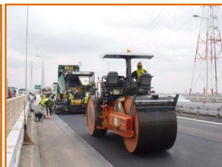
【アスファルト舗装施工状況※】
