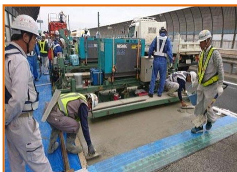
【鋼繊維補強コンクリート打設状況※】
