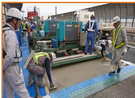
【鋼繊維補強コンクリート打設状況※】
