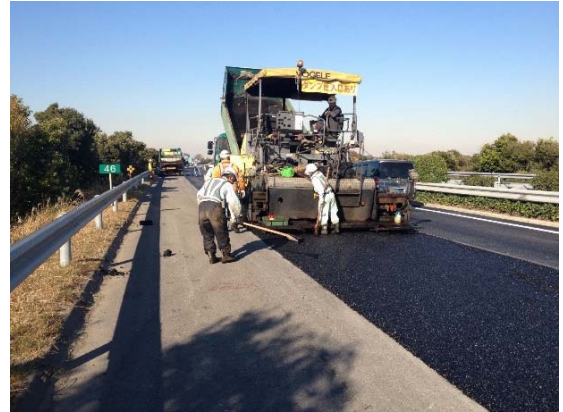
舗装補修工事状況写真
