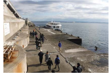
非常用船舶接岸施設
