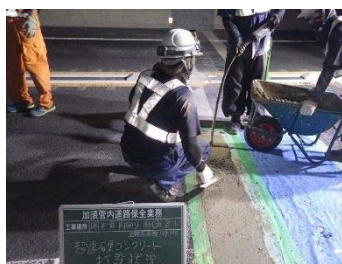
伸縮装置補修工事
