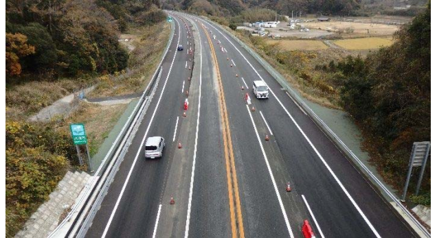
君津市作木付近 舗装状況(南から北を臨む)
