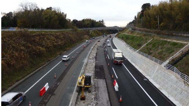
君津市六手付近 舗装状況(北から南を臨む)
