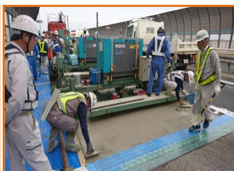
【鋼繊維補強コンクリート打設状況※】
