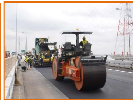
【アスファルト舗装施工状況※】
