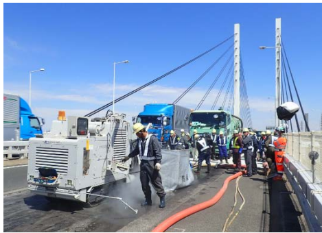
写真 ウォータージェット施工状況
