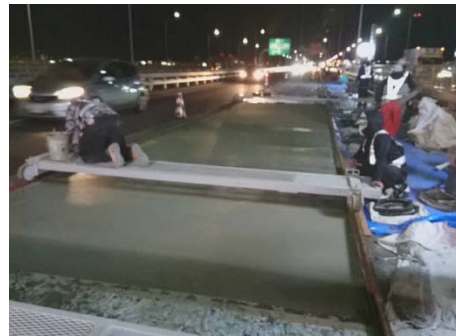
写真 鋼繊維補強コンクリート施工状況
