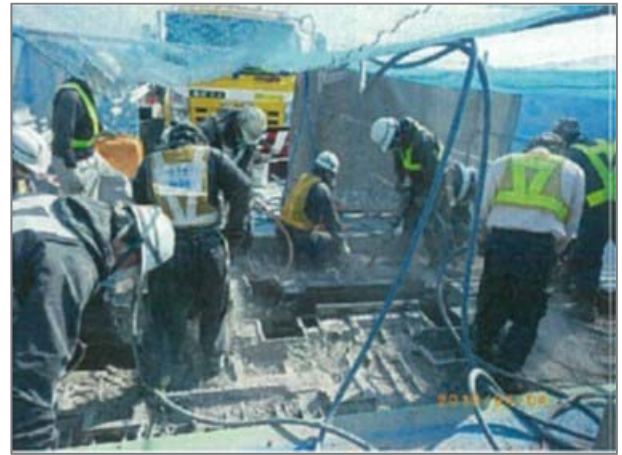
2. 伸縮装置の撤去
