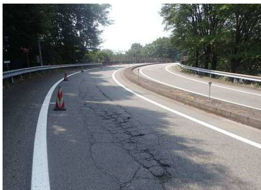
舗装損傷状況
