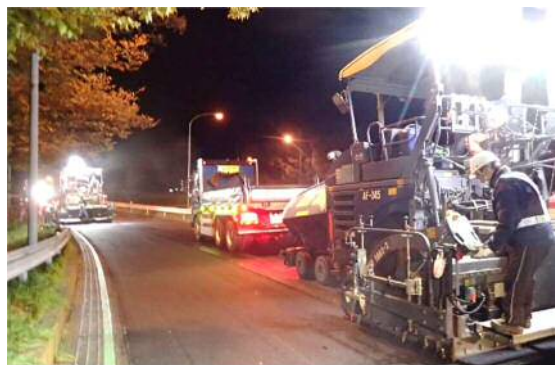
舗装補修工事 作業状況
