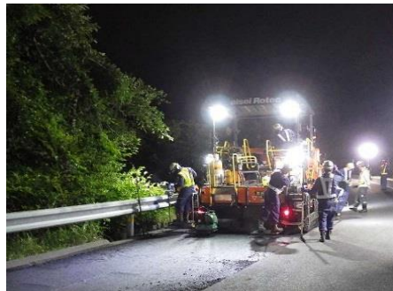
舗装補修工事 作業状況
