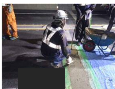
伸縮装置補修工事
