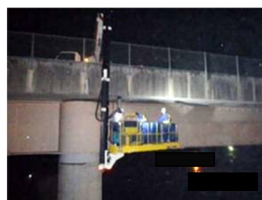
道路構造物点検
