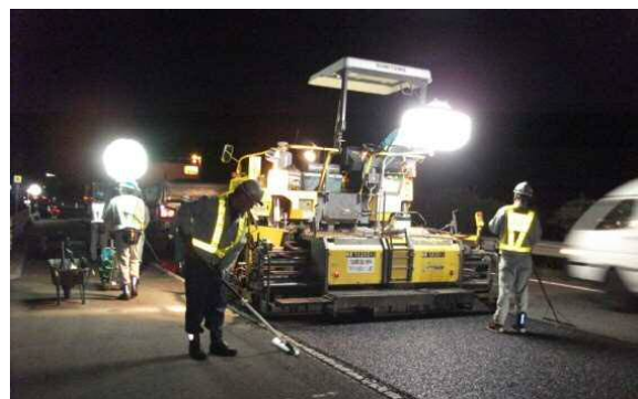
舗装補修工事 作業状況
