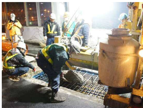
床版部分補修工事 作業状況
