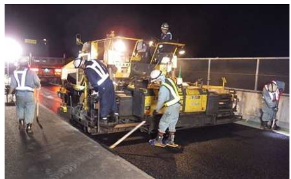
舗装補修工事 作業状況
