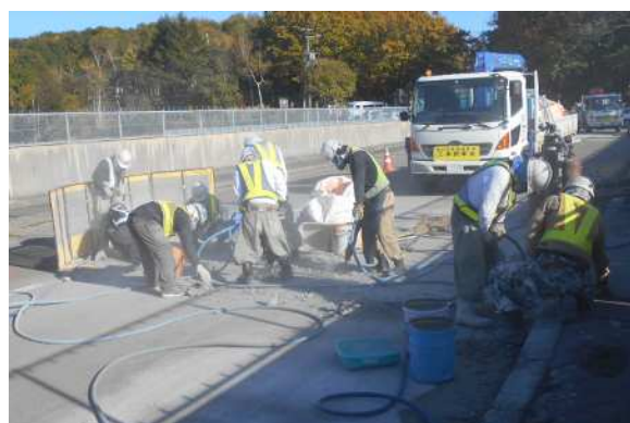
伸縮装置取替状況
