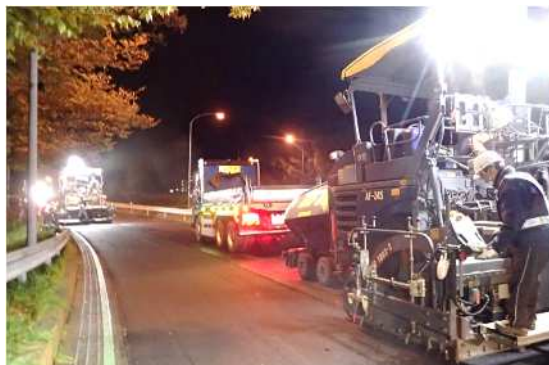
舗装補修工事 作業状況
