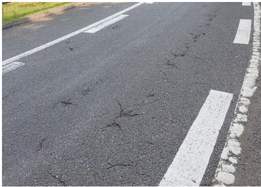
舗装損傷状況
