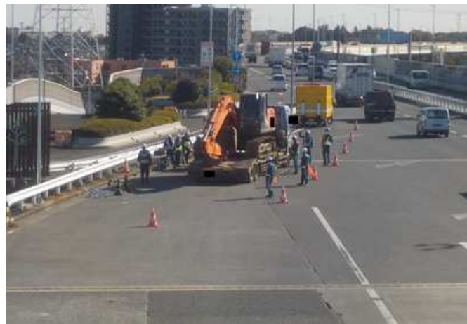
⑤【首都高速道路(株)】川口本線料金所
