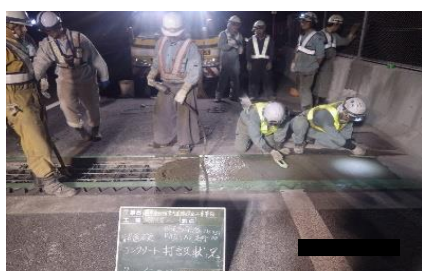
コンクリート打設状況
