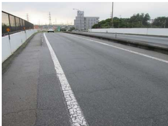
舗装損傷状況
