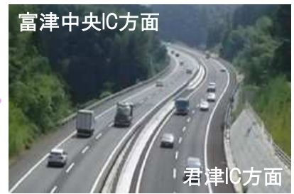
4車線化後の減少状況 君津IC～富津中央IC 君津PA付近 R1.8
