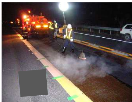
舗装補修工事
