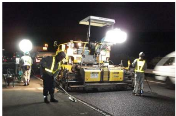
舗装補修工事 作業状況
