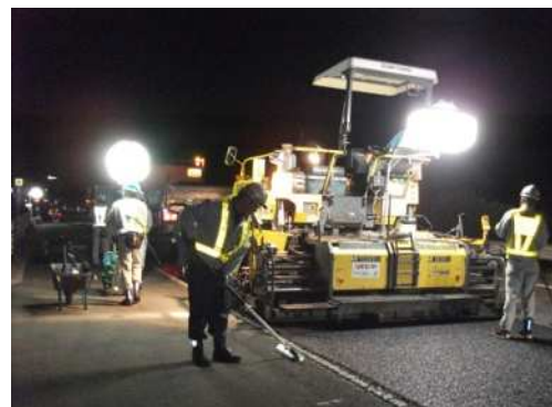
舗装補修工事 作業状況
