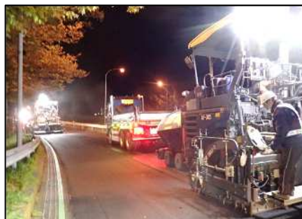
舗装補修工事 作業状況
