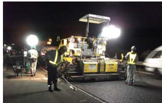
夜間舗設作業状況
