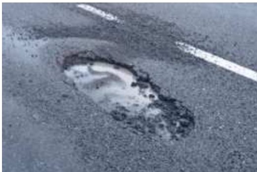
現況舗装状況
