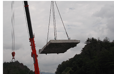
既設コンクリート床版の撤去※
