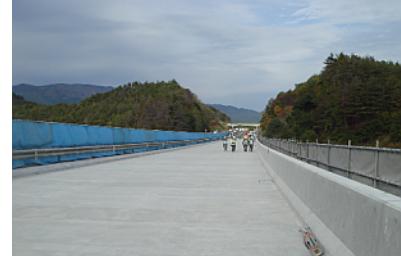
新設コンクリート床版施工完了※
