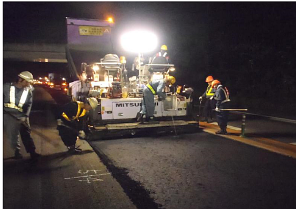
舗装補修工事 作業状況
