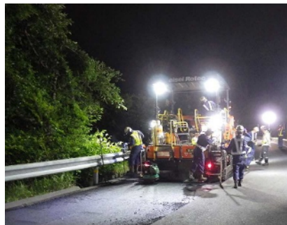
舗装補修工事 作業状況
