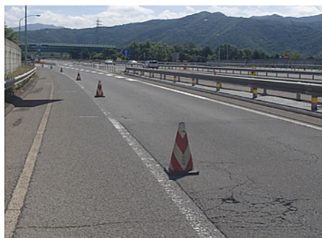
舗装補修工事 施工前イメージ
