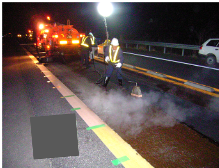
舗装補修工事
