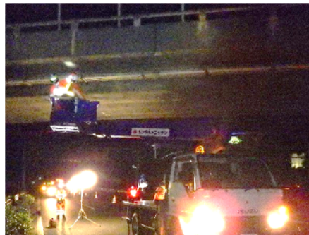
道路構造物の点検
