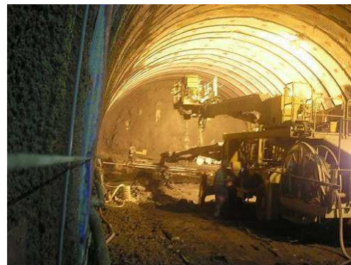
薬師岳トンネルの掘削状況
