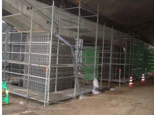
橋脚の耐震補強
