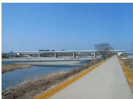
本線工事用道路として先行整備された 胎内川に架かる胎内川橋
