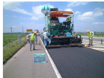
アスファルト舗装の舗設
