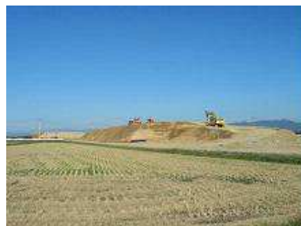
本線工事に先立ち実施している載荷盛土工事（荒川 IC 付近）
