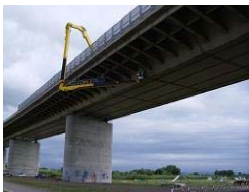
【橋梁点検車を用いた橋梁点検】
