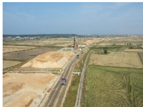
鋭意盛土施工を実施している（荒川 IC 付近）
