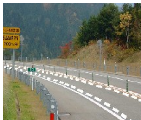
導流レーンマーク
