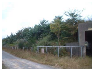
樹林化施工4年後の育成状況
