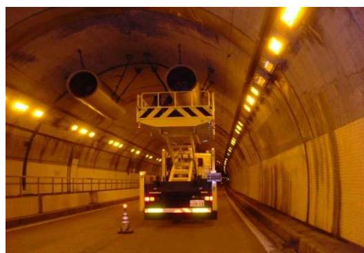
【トンネル換気設備構造検査】
