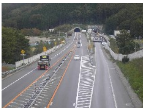
薬師岳トンネル坑口の状況
