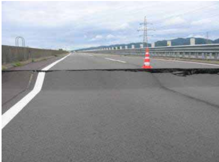
北陸道西山～柏崎 下り402.2kp 吉井川橋
