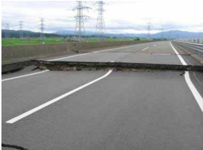
北陸道西山～柏崎 上り402.2kp 吉井川橋
