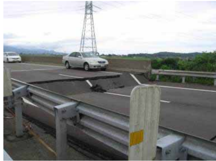
北陸道西山～柏崎 下り402.2kp 吉井川橋
