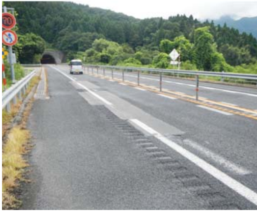
舗装路面の補修(安田IC～三川IC間)
