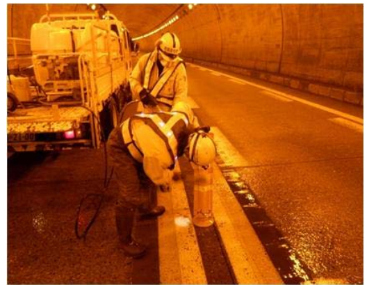
車線分離標の清掃
