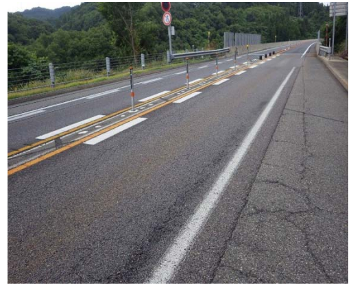
舗装路面の補修(津川IC～西会津IC間)
