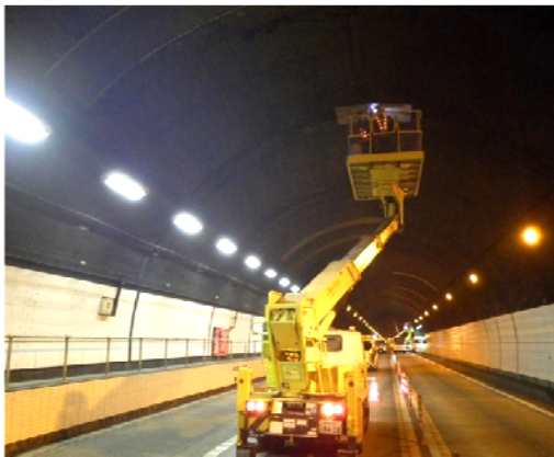
トンネル内構造物の点検・補修
