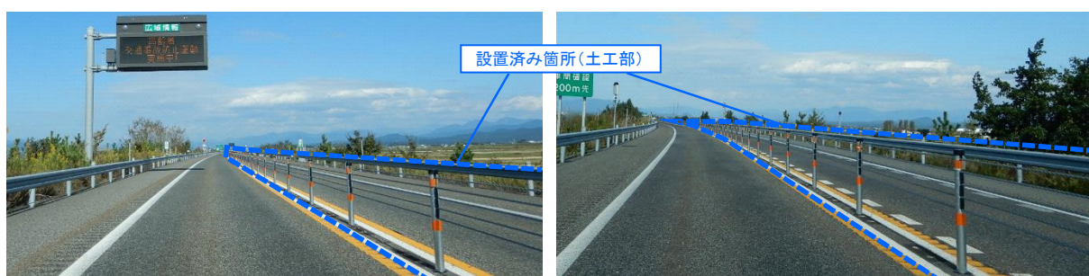
ワイヤロープ設置後の状況(今年4月に設置済み)
